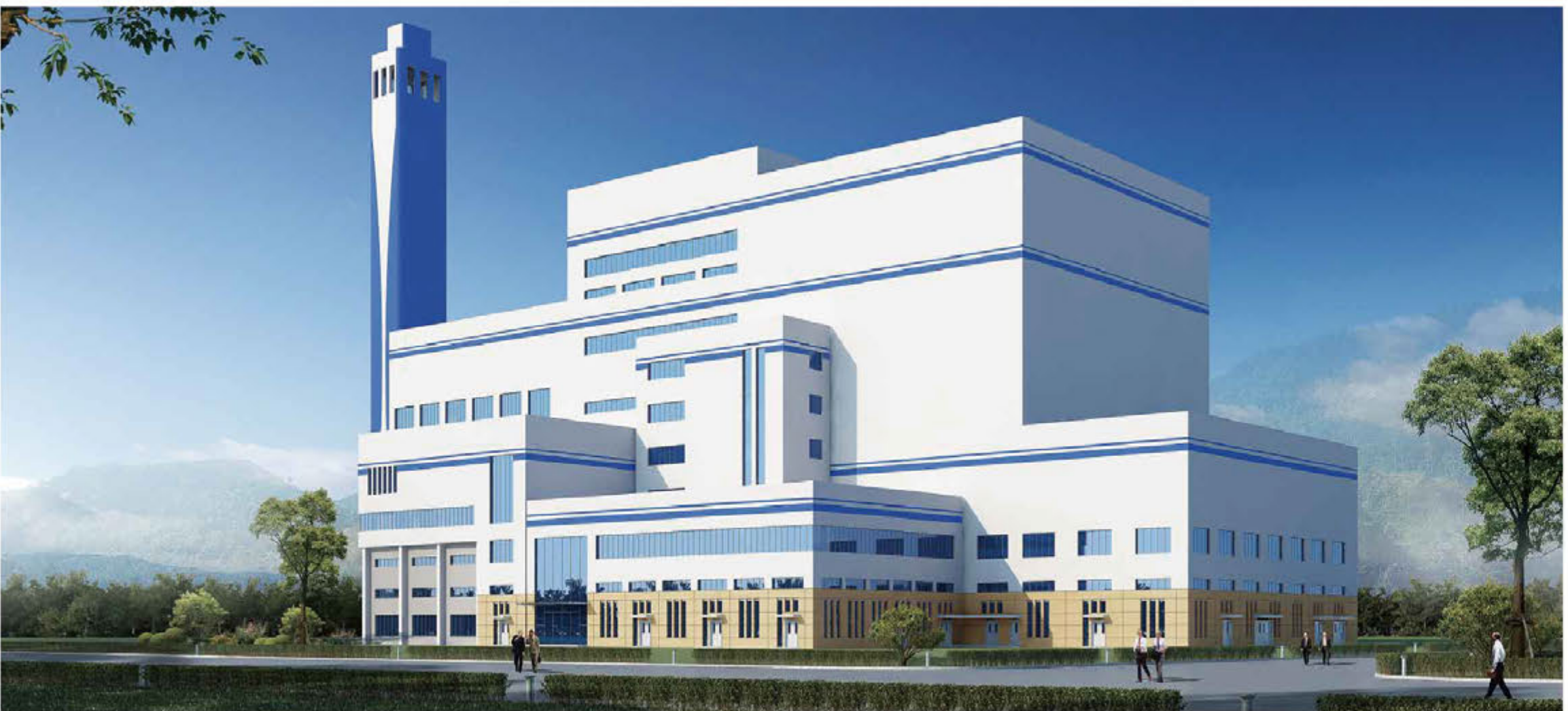
▲ 生活垃圾焚烧发电厂
